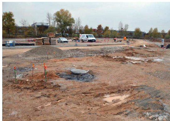
Sous le parking de 100 places encore en chantier, sept puits géothermiques ont été creusés pour chauffer le sol des espaces pieds nus.
